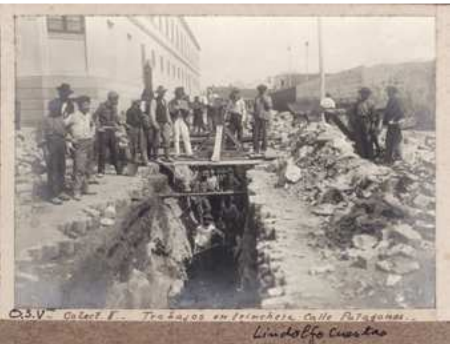
Fotografía de trabajadores durante la construcción del colector II del saneamiento del Puerto de Montevideo, años 1903-1906. Fuente: Centro de Fotografía de Montevideo, Foto: 045FPEK.CDF.IMO.UY. Fotografía: S.d. Donación: Ernesto Katzenstein (hijo).
